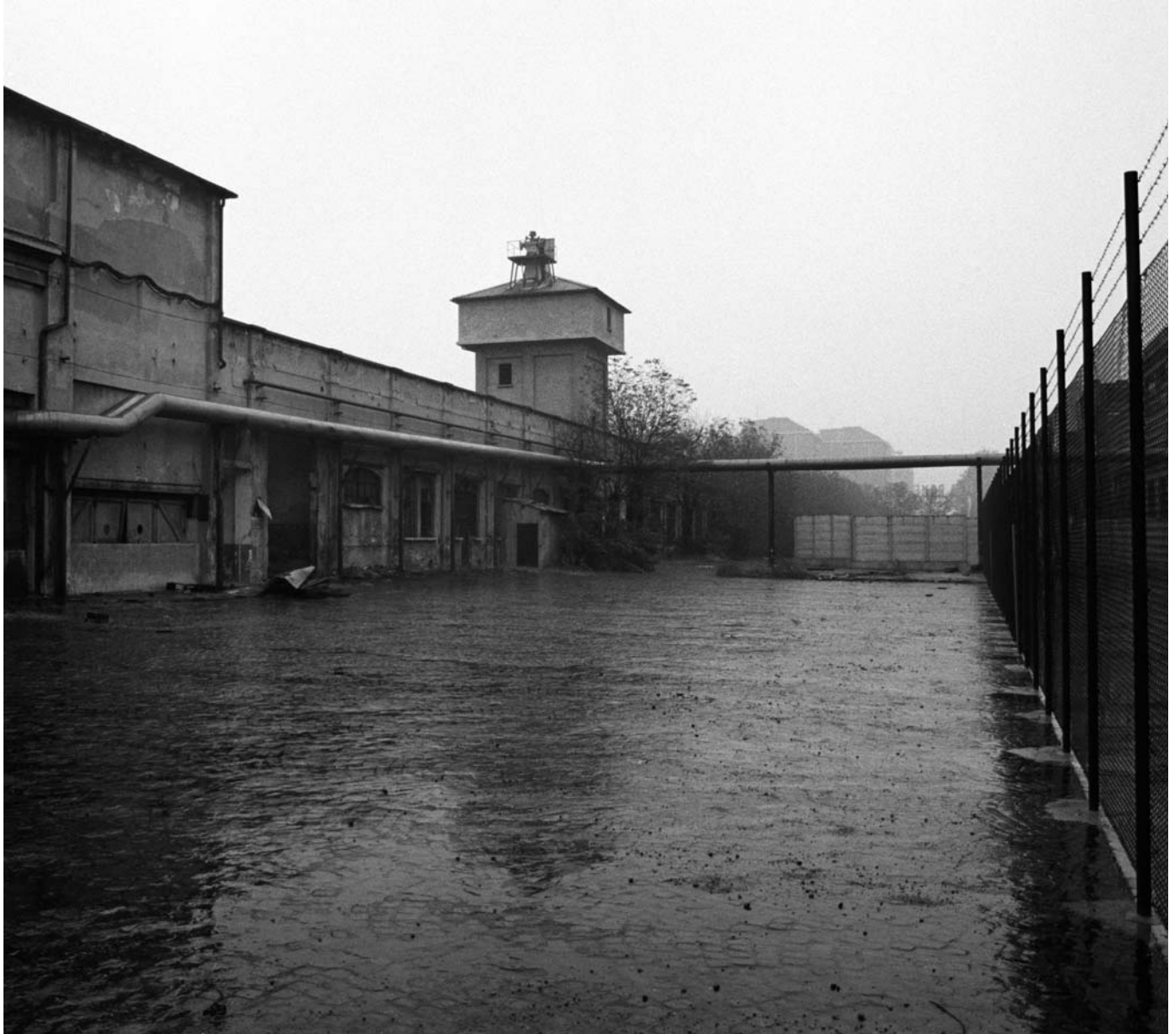
Foto di Isabella Colonnello in Dove era la fabbrica , Milano 1987 - Alfa Romeo, Portello - Milano
